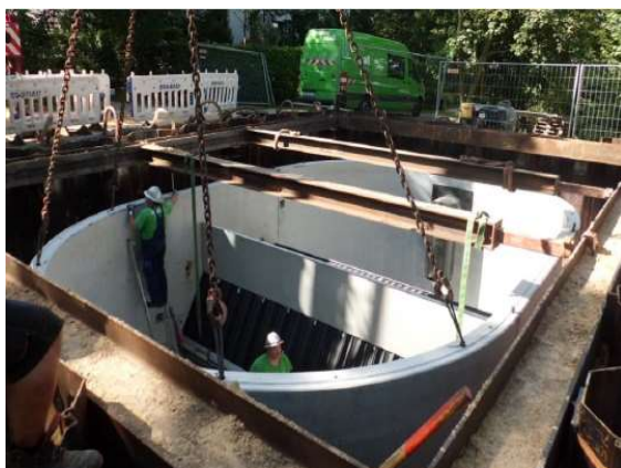
Esempi di posa sedimentatori lamellari VIATUB
