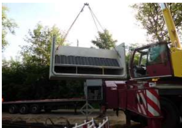
Esempi di posa sedimentatori lamellari VIATUB
