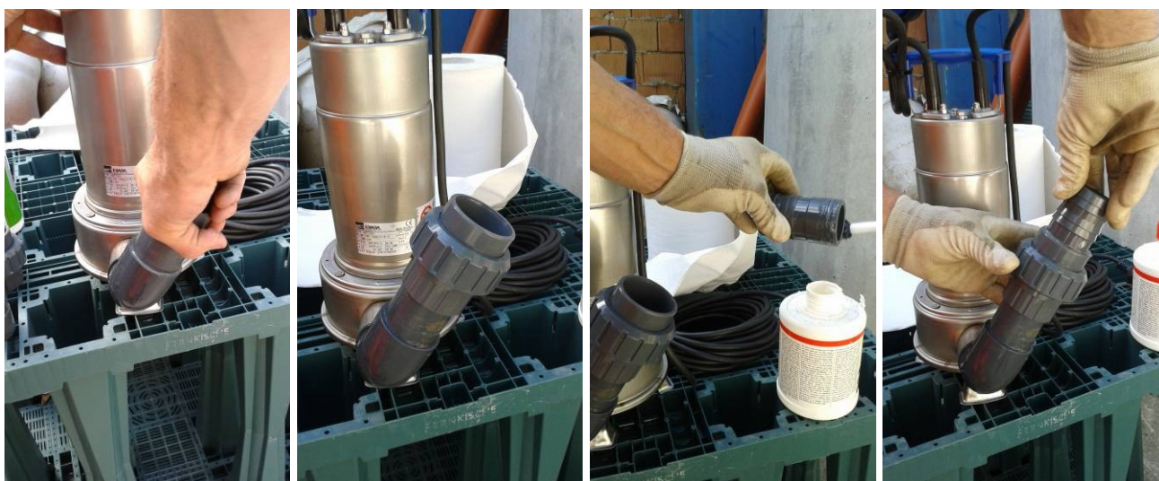
Fissaggio raccordi rigidi alla pompa
