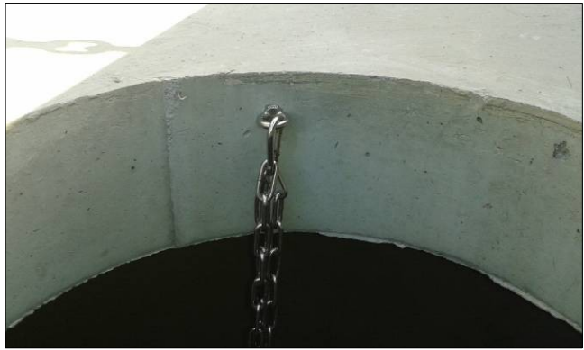
Particolari galleggiante e catena di estrazione pompa
