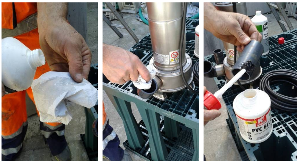
Fissaggio curva a gomito alla pompa
