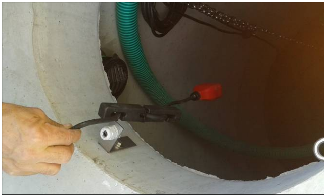
Particolari galleggiante e catena di estrazione pompa
