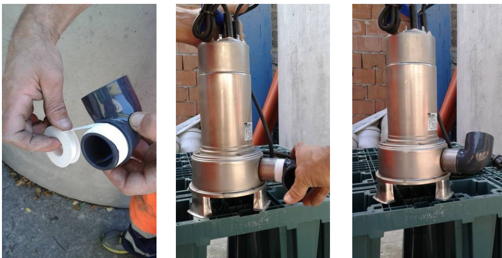
Fissaggio curva a gomito alla pompa
