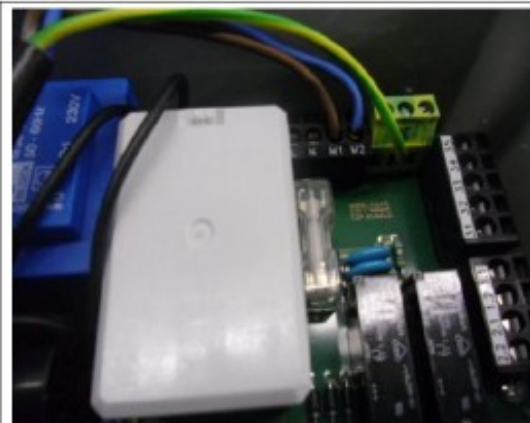
Collegamento pompa
