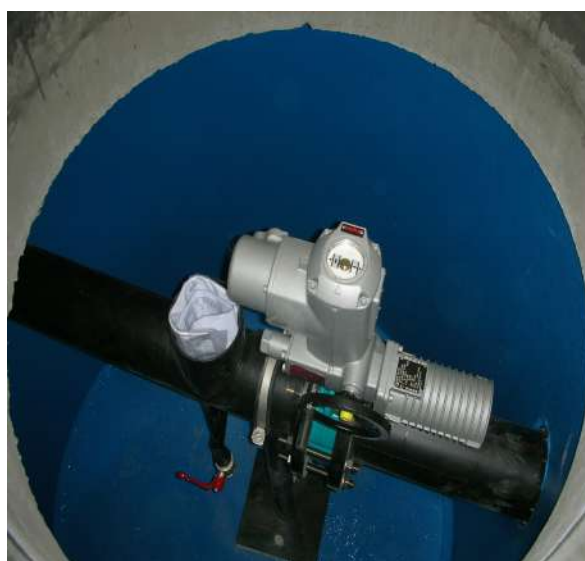
Vasca NEUTRASab e tubazione con fori e saracinesca automatica
