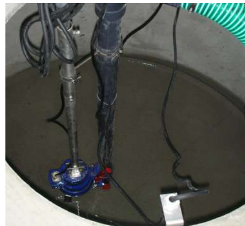
Pozzetto deviatore con sensore Vasca d'accumulo con pompa e sensore
